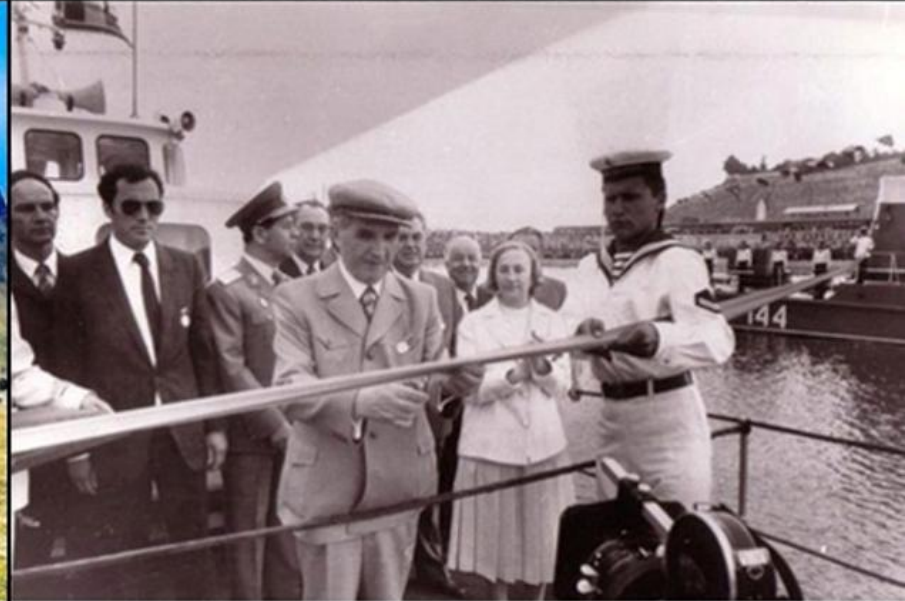
Inaugurarea Canalului Dunăre-Marea Neagră (1984)
