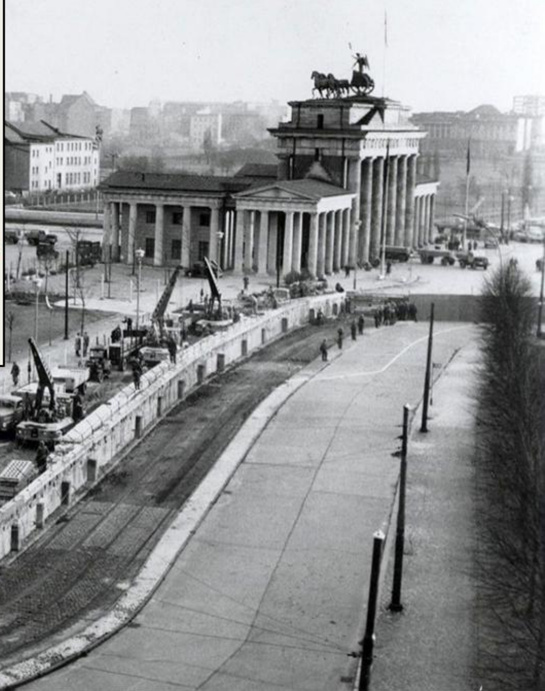
Muncitori din R.D.G. construiesc Zidul Berlinului (1961)
