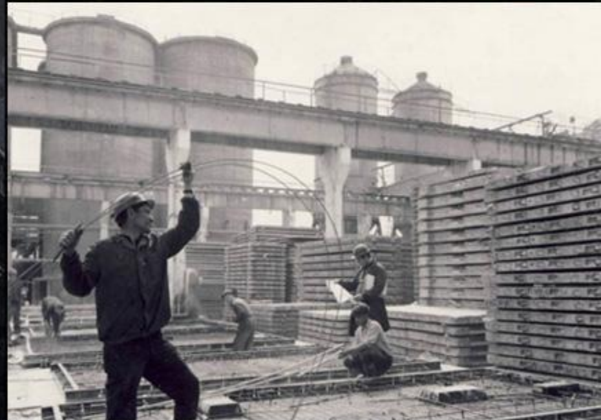
Șantierul unui complex industrial din perioada comunistă
